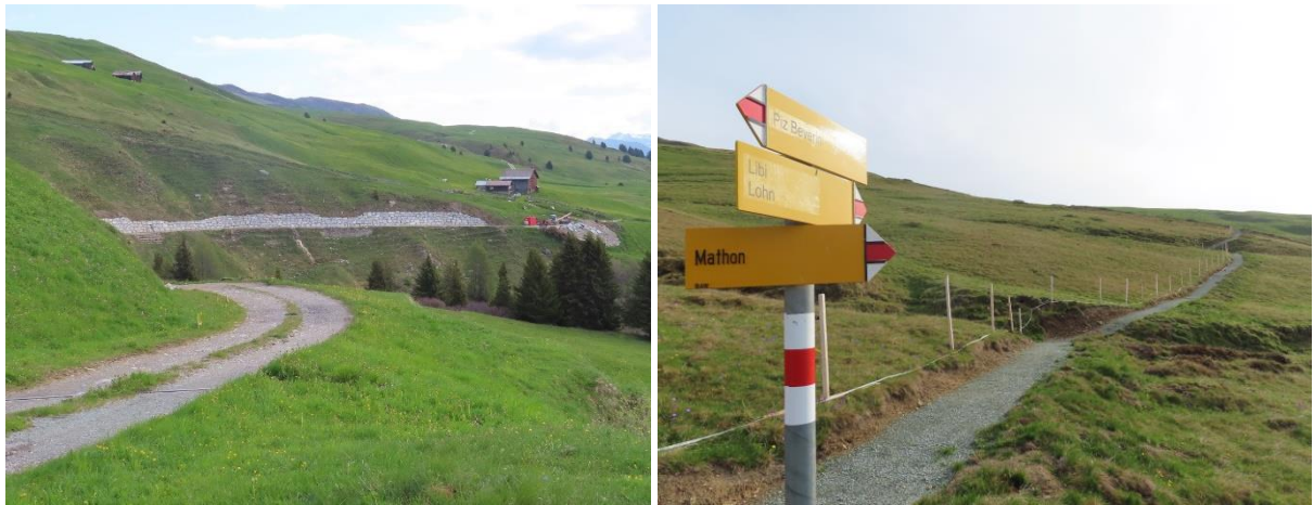
Abb. 2. Links: Sanierungs- und Befestigungsarbeiten bei der Verbindungsstrasse Mursenas –Murer (31.5.23, Foto: E. Nicca), rechts: Neu- u. Ausbau Wanderweg bei «Liebtgas» Richtung Libi, umgesetzt 2022 (30.05.23, Foto: E. Nicca).
